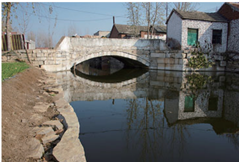
圖 12 此為未重修之魯橋鎮棗林閘古跡，位於 35^{\circ}9'44.97'' 北， 116^{\circ}41'24.64'' 東。閘上之交通橋為 1992 年所建，與閘無關。橋兩側為古跡，建橋用石亦取於古閘壩。閘外水面最寬 29 米，不等，多為民房侵奪。
