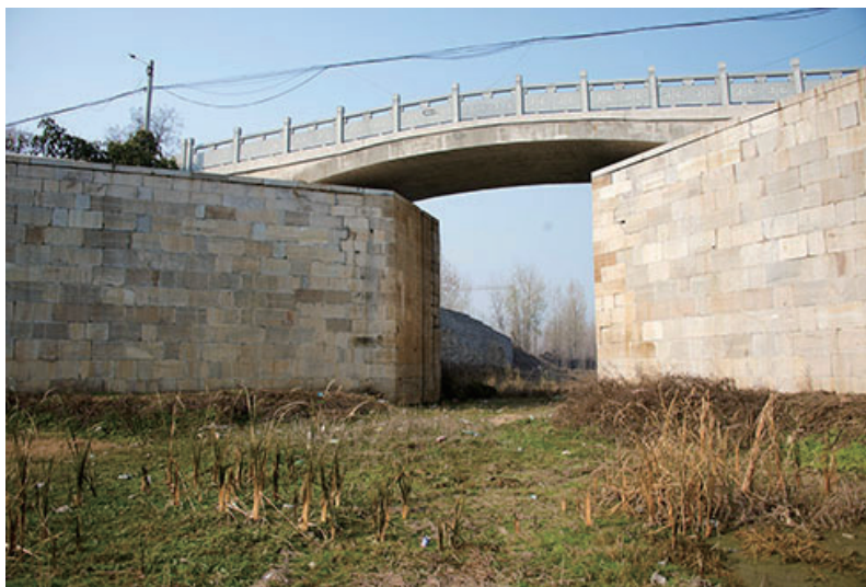
圖 11 此為 2015 年修復的南旺鎮柳林閘，位於 35^{\circ}34'34.97'' 北， 116^{\circ}23'15.82'' 東。閘體石色不同，色深者古跡，色淺者方是新補。閘外兩翅寬約 35 米。跨於閘上之橋，為便利居民，與閘無關。
